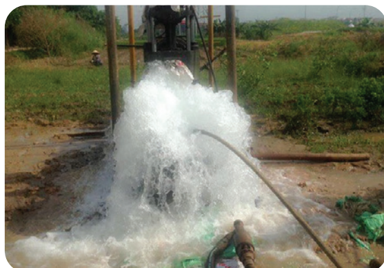
Hình 6.5. Khoan giếng lấy nước cung cấp cho sinh hoạt và sản xuất nông nghiệp ở tỉnh Quảng Ngãi
